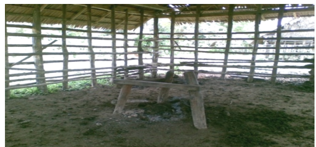
Gambar 9. Kayu tore untuk pagar api unggun
