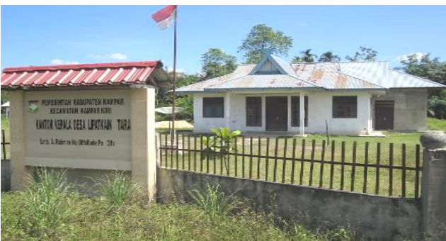
Gambar 4. Pembangunan Kantor Desa Desa Lipat Kain Utara
