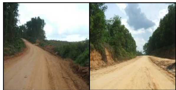
Gambar 6. Peningkatan Pembangunan Infrastruktur Jalan di Desa Lipat Kain
