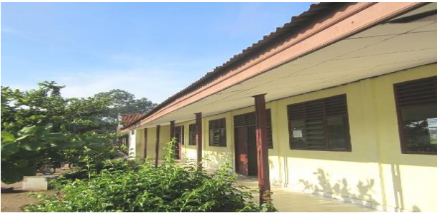
Gambar 3. Pembangunan Sekolah SMKN 1 Petapahan
