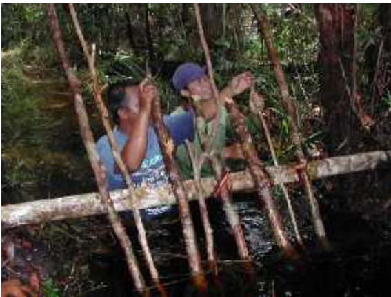
Gambar 6. Pembuatan Kanal Blocking untuk rewetting (pembasahan) rawa gambut di Provinsi Riau
