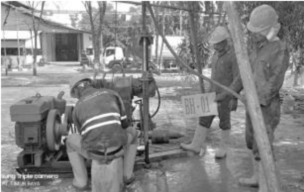
Gambar 1. Pengeboran Geoteknik dan Pengambilan UDS ( Undisturbed Sample ) Tanah. Sumber: Dok. PT. Geosindo Utama
